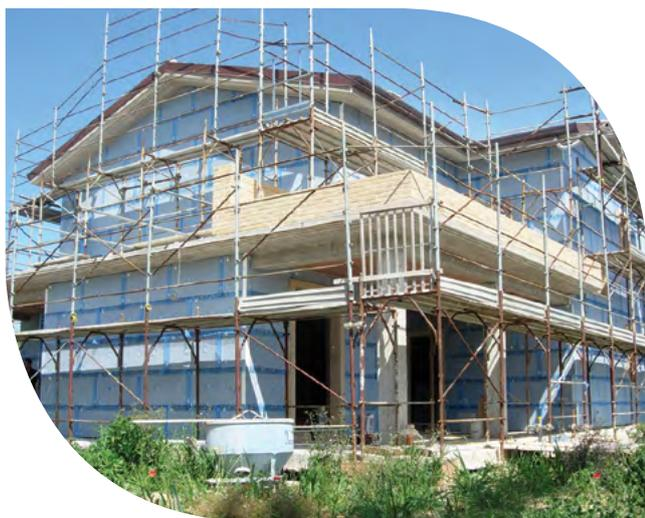
Le Système **ECAP®** est un procédé d'Isolation Thermique par l'Extérieur (ITE) qui utilise des plaques en polystyrène semi-finies. Les plaques ont reçu, en cours de fabrication, un traitement qui révolutionne les temps de pose en simplifiant le scénario des opérations.
